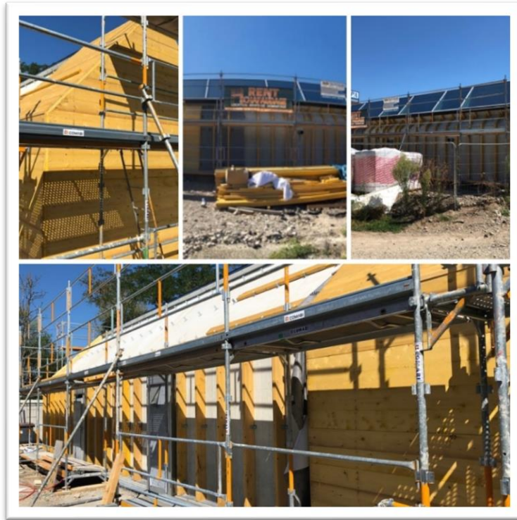
Nouvelle fourrière et quarantaine pour chats en cours de construction
