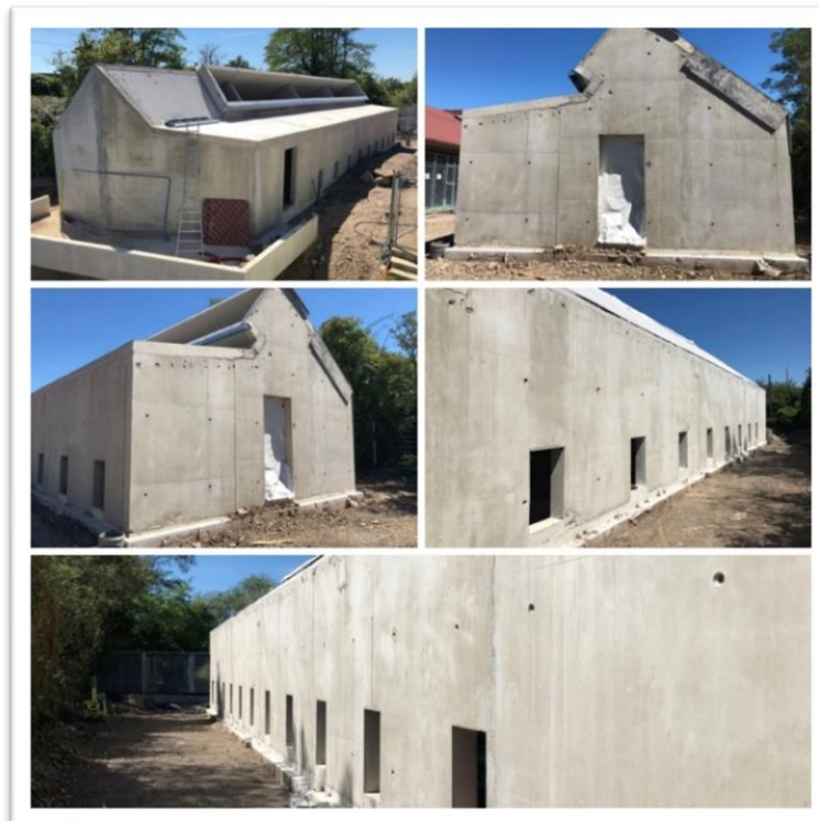
Pension canine en cours de construction
